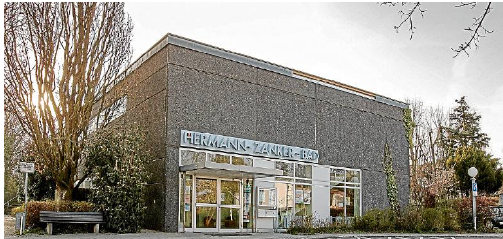
Das Hallenbad ist sanierungsbedürftig.
